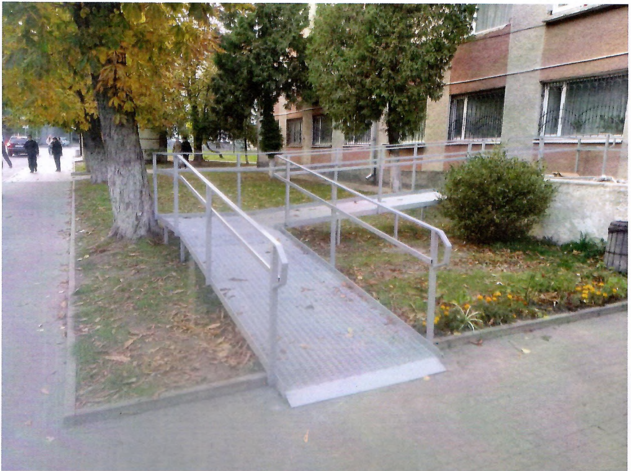
Загальний вигляд пандуса
